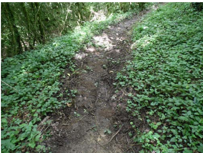
Remise en état du sentier avec terre végétale
